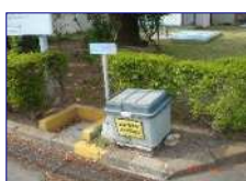
吸油マットの設置
