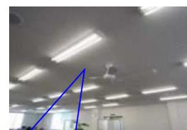
シーリングファンで室内空気を循環させる事で、冷暖房効率が向上
